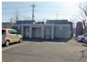
駐車場公衆トイレ外観
