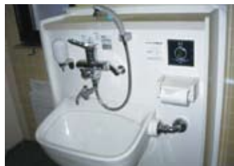
オストメイト対応設備
